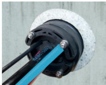
6. Ringraumdichtung in das Futterrohr bzw. die Kernbohrung einfügen.
