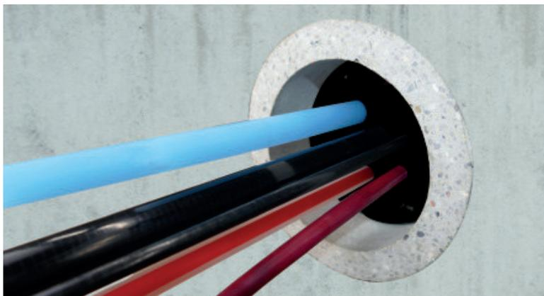
1. Futterrohr/Kernbohrung und Mediumrohre / Kabel reinigen.
