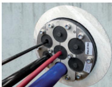
5. Medienleitungen bzw. Kabel in die vorbereiteten Öffnungen einführen.
